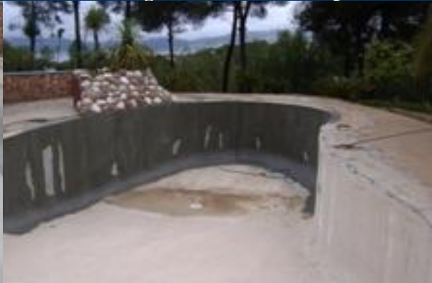
Poolabdichtung Wand u. Boden April 2008
