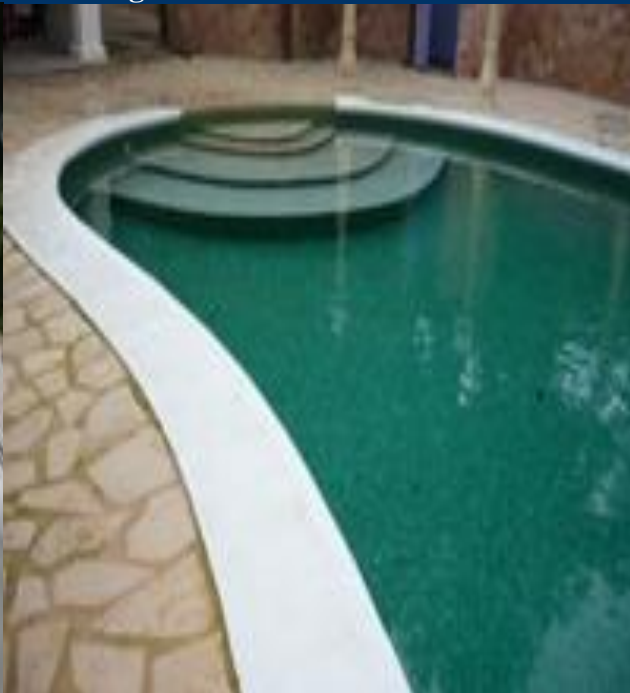
Übergabe unserer Arbeiten 6 Juni 2008
