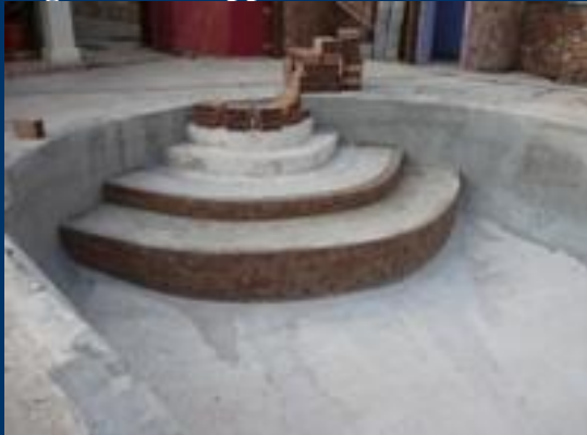
Beginn Pooltreppe März 2008
